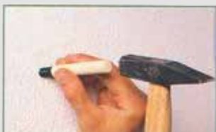
Infilare il perno con l'apposito supporto
