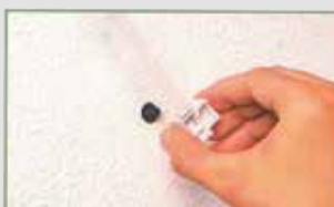
Montaggio del collare con base
