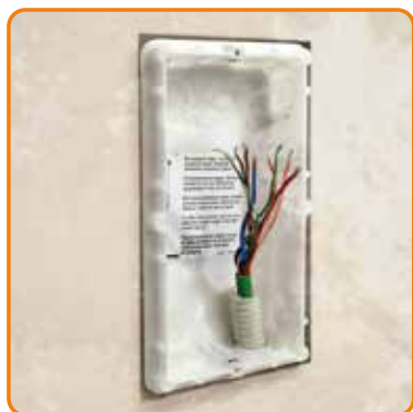
Rimuovo il posto esterno esistente
