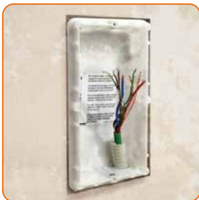
Rimuovo il posto esterno esistente
