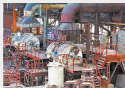
AMBIENTI CON MISCELE ESPLOSIVE: METALLURGIA E VERNICIATURA
