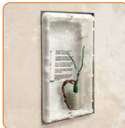
Utilizzo una coppia di cavi presenti per collegare il nuovo posto esterno 2 fili
