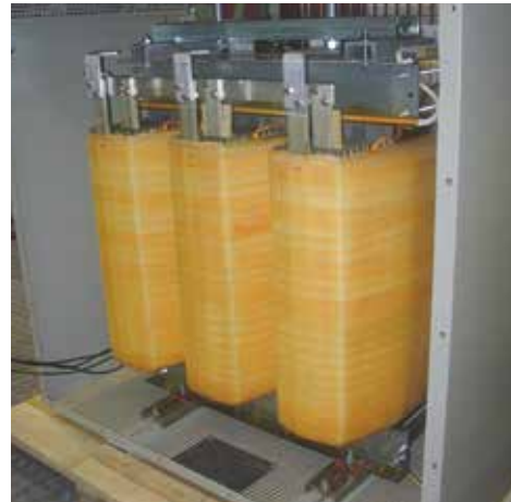
400 kVA con avvolgimenti in alluminio
