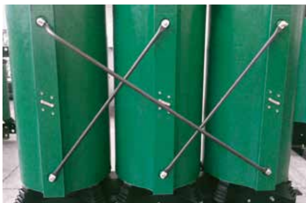
Esempio di terminali MT
