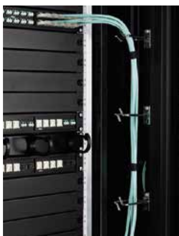
Anelli fissati alla struttura
