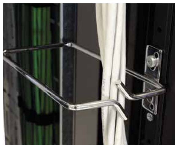
Anelli fissati alla struttura
